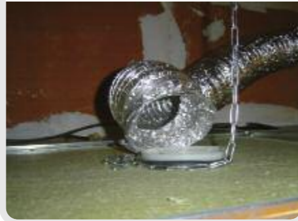
Photo 12 : Bouche déconnectée au-dessus du plafond
