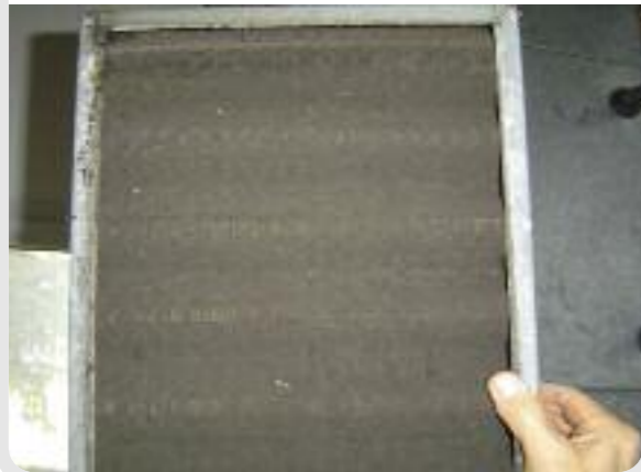
Photo 15 : Filtre de CTA très encrassé
