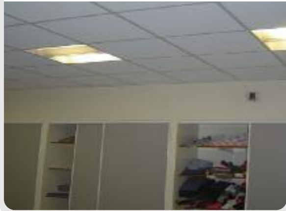
Photo 13 : Bouches d'extraction d'air dans un dortoir
