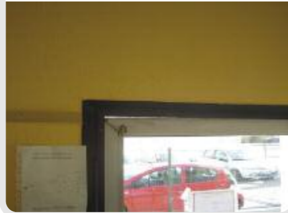
Photo 14 : Porte-fenêtre non étanche à l'air (jour visible)
