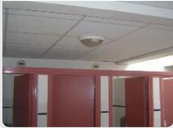
Photo 11 : Bouches d'extraction dans des sanitaires
