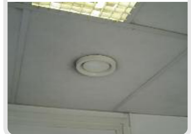
Photo 10 : Bouche de soufflage d'air dans une cantine
