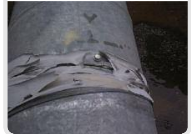
Photo 6 : Adhésifs détériorés sur conduits extérieurs
