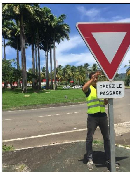
Les tubes sont posés à environ 2 mètres du sol, essentiellement pour des raisons de vandalisme, sur des supports (lampadaire, poteau...) et restant représentative de l'air respirable. Les tubes sont posés sur des supports qui sont fixés au poteau à l'aide de collier de serrage.
