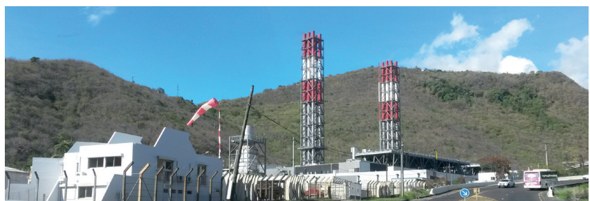
NOUVELLE CENTRALE THERMIQUE DE BELLEFONTAINE
