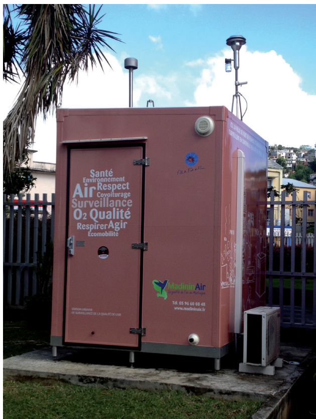
Figure 19. Site de Fort-de-France, Hôtel de Ville
