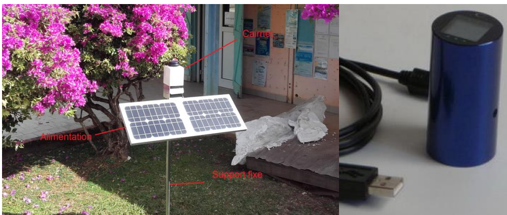
Figure 5: A gauche un dispositif Cairpol installé sur le site du front de mer dans la commune du Robert. A droite un Cairsens dédié à la mesure de l'H 2 S.
