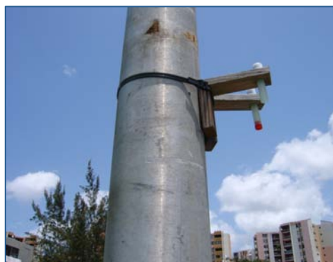
Mise en place des tubes NO 2
