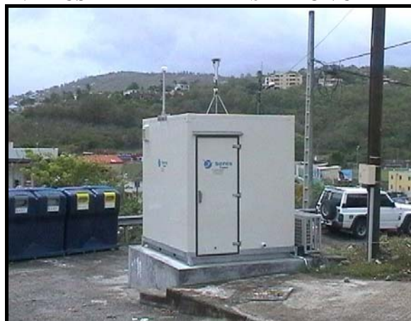
STATION URBAINE DE SCHOELCHER
