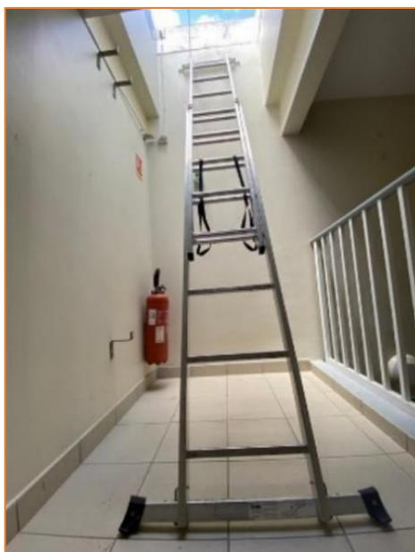
Figure II-5 : Echelle sécurisée intérieure
