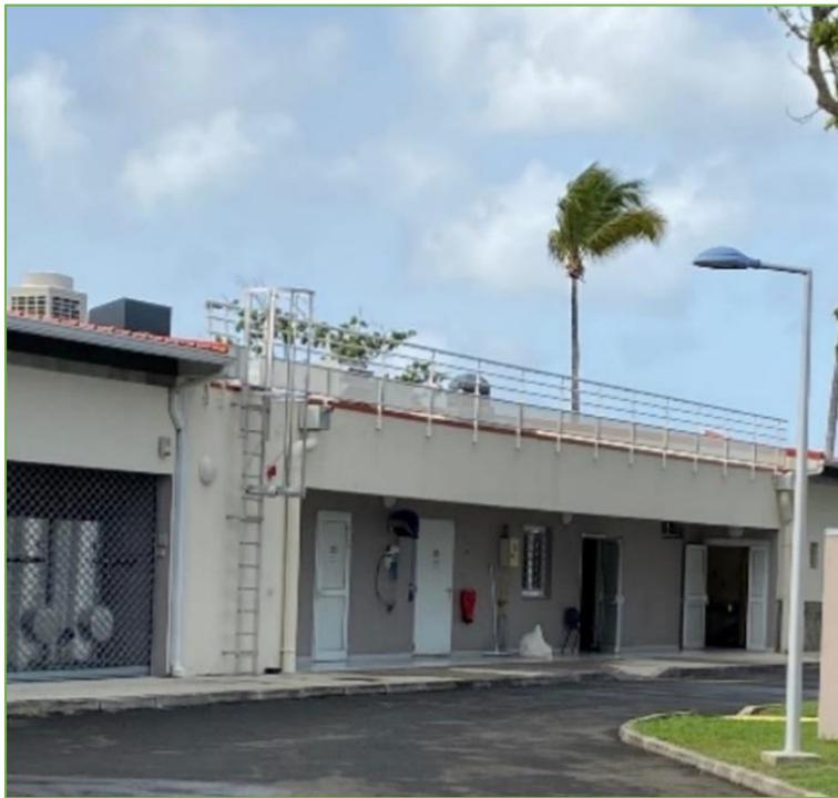
*Figure II-6 : Echelle sécurisée extérieure*
